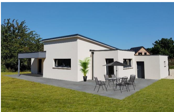
Construction Maisons Stéphane Berger certifiée E+C-, à Dasle
